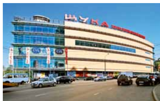
Торговый центр Щука, г. Москва
