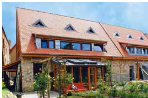
Памятник архитектуры после реконструкции. Бывший табачный склад, г. Фирнхайм (Германия).
