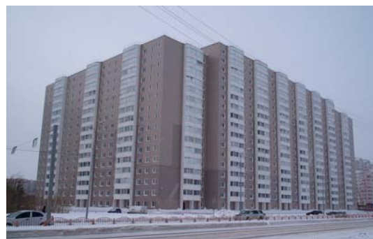
Жилой комплекс «Никольский», г. Сургут
