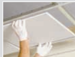
Каждая панель является полностью съёмной.
