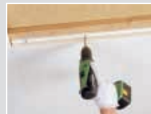
Монтаж панелей Master F с помощью шурупов
