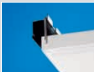
Примыкание панели Access E к стене с помощью пристенного уголка Access Wall trim
