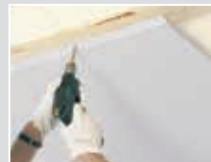
Крепление панелей Focus F при помощи шурупов.
