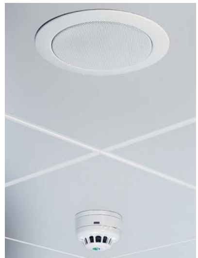
▲ Многообразие инженерных систем требует от производителя гибких технических решений
