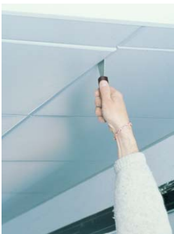
▲ Демонтаж направленным вниз резким движением
