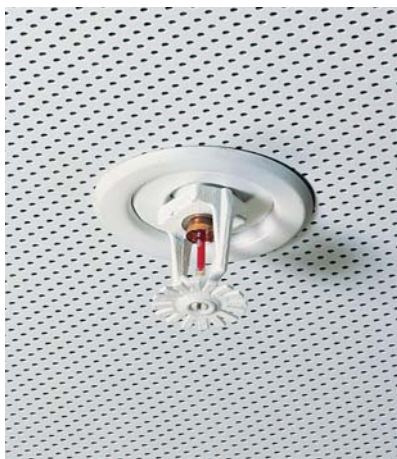
▲ Головка спринклера, вставленная в отверстие округлой формы
