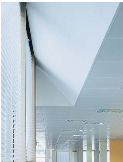
▲ Пристенный C-канал и подрезанные панели Clip-In
