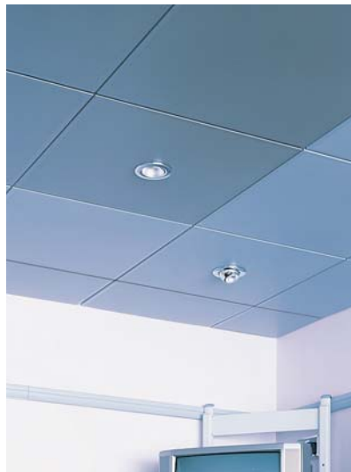
▲ Панели нестандартного размера для отделки потолка вдоль стен помещения
