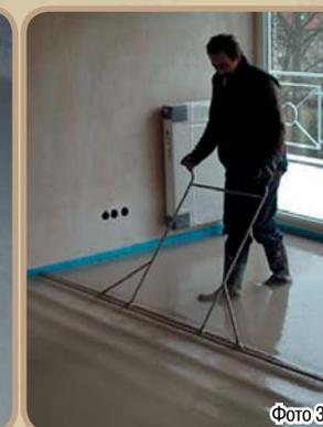
1. Готовый раствор нанести на подготовленную поверхность, наливая при помощи шланга (при работе через растворосмеситель) (фото 1), либо разлить полученный раствор вручную (фото 2) до уровня предварительно выставленных маячков. При необходимости разровнять правилом, прокатать аэрационным валиком.
