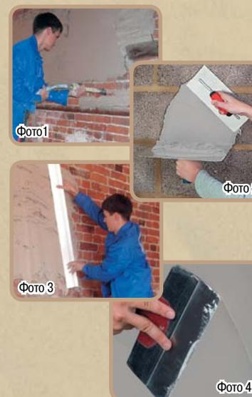
1. Полученный раствор нанести на поверхность через растворосмеситель, согнувшись при помощи пистолета на поверхность (фото 1), либо набросать на поверхность при помощи штукатурного ковшика или мастерка (фото 2).
