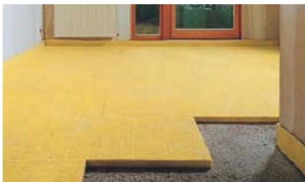
Благодаря высоким демпфирующим свойствам плиты ISOVER Плавающий Пол обеспечивают максимальную защиту от ударного шума.
