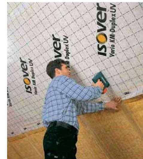
Для пароизоляции зданий ISOVER предлагает инновационную мембрану ISOVER VARIO KM Duplex UV и базовую мембрану ISOVER VS 80.
