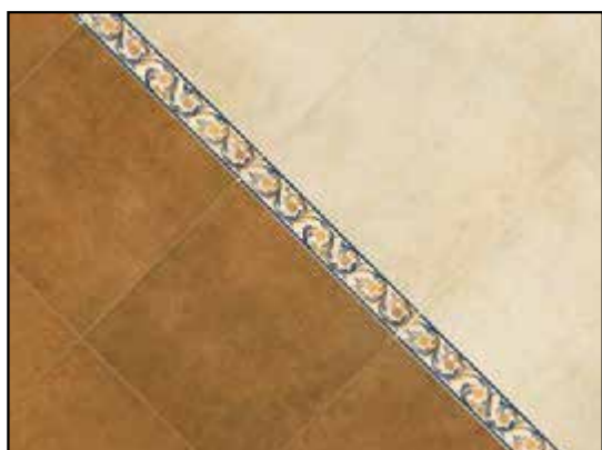
Укладка 4 / Posa 4 / Installation 4
