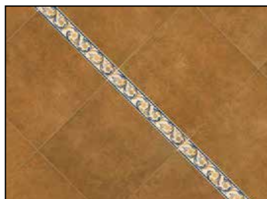
Укладка 8 / Posa 8 / Installation 8
