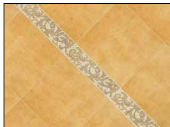
Укладка 6 / Posa 6 / Installation 6
