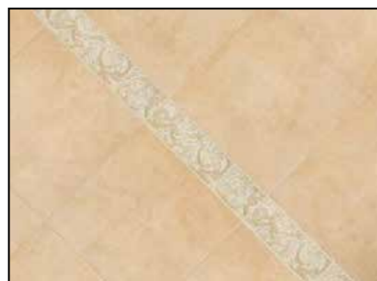
Укладка 9 / Posa 9 / Installation 9
