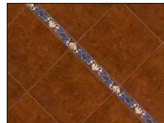
Укладка 17 / Posa 17 / Installation 17
