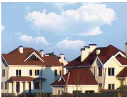
Коттеджный поселок «Крона», г. Москва
